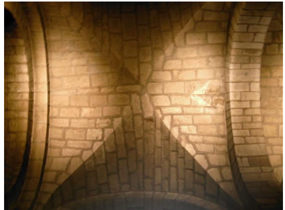
Bóveda de arista: formada por la intersección de dos bóvedas de cañón.
